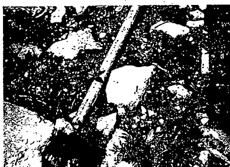
Slika 12. i 13.: Improvizirani sustav odvodnje sanitarno – potrošnih voda
