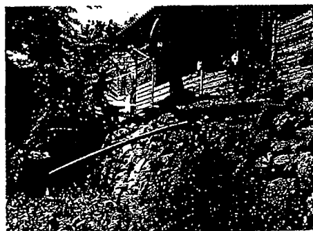
Slika 12. i 13.: Improvizirani sustav odvodnje sanitarno – potrošnih voda
